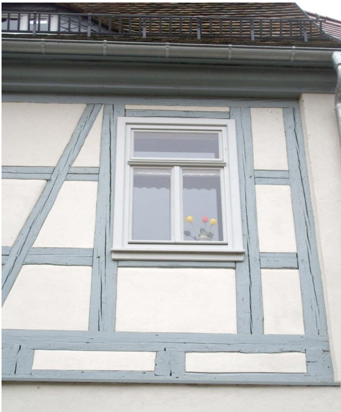
Bild 12: Dieses neue, alte „Gesicht“ (neue Kastenfenster!) der Straßenfassade brachte dem Kulturdenkmal Badergasse 4 die Bezeichnung „Blaues Haus“ ein.
