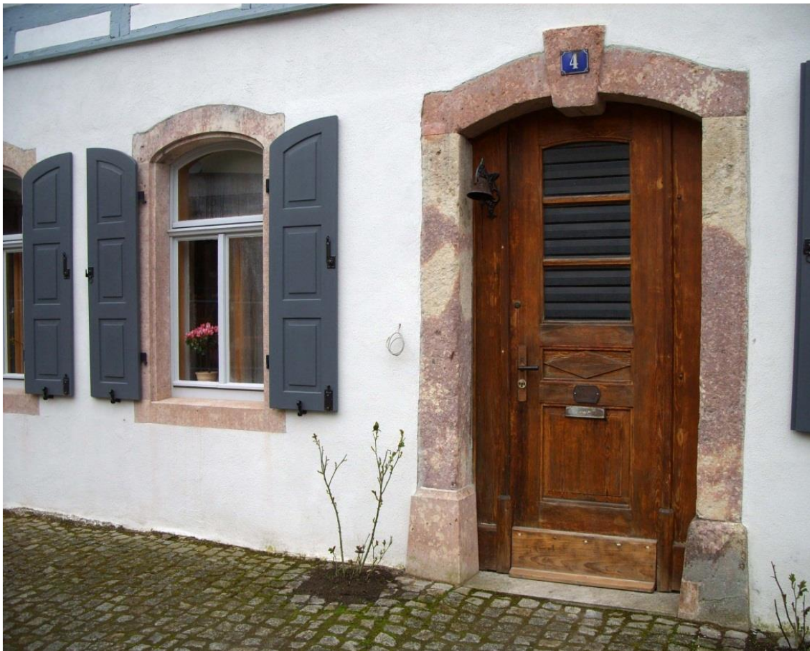
Bild 13: Mit Rückbaumaßnahmen im Erdgeschoß der Straßenfassade (hier auch die originale Eingangssituation) wurde der ursprüngliche Bauzustand des 17. Jahrhunderts wieder hergestellt. Die stilvolle Haustür wurde aufgearbeitet.
