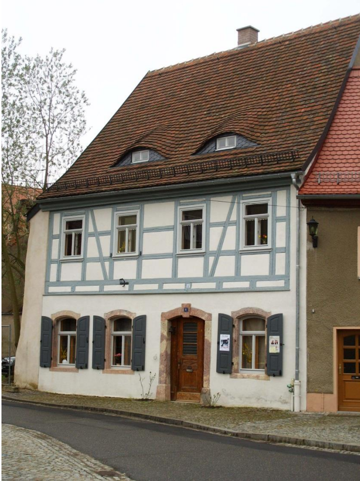
Bild 22: Die Fassaden, hier auf der Straßenseite bestehend aus dem nach 1788 wieder erstandenen Fachwerk und dem 2011 wieder hergestellten Zustand des 17. Jahrhunderts, sind optisch abgegrenzt von der Giebelmauer und von den eher unförmigen Mauerstützen, die aber bewusst an die Fassadenreste des ehemaligen, abgebrochenen Kulturdenkmals Badergasse 3 erinnern sollen.
