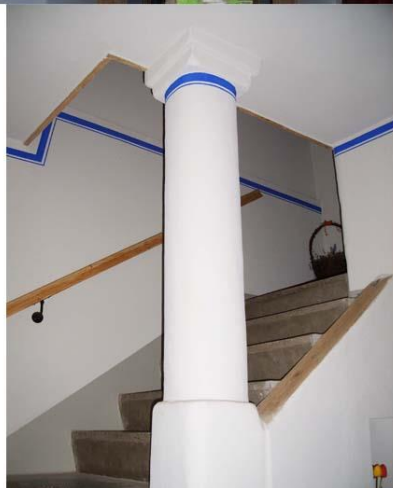
Bild 17: Gewölbebögen aus dem 17. Jahrhundert sowie ein Treppenhaus mit Säule - dieses und die gesamte Farbfassung wurden restauriert nach dem Originalbefund aus dem 18. Jahrhundert - empfangen heute wieder im historischen Ambiente den Besucher schon im EG-Flur.
