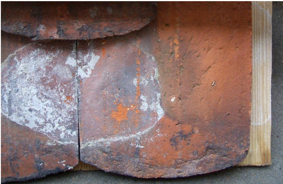
Bild 5: Abdeckung eines Teils der Fugen zwischen den Dachziegeln mit Holzspließen
