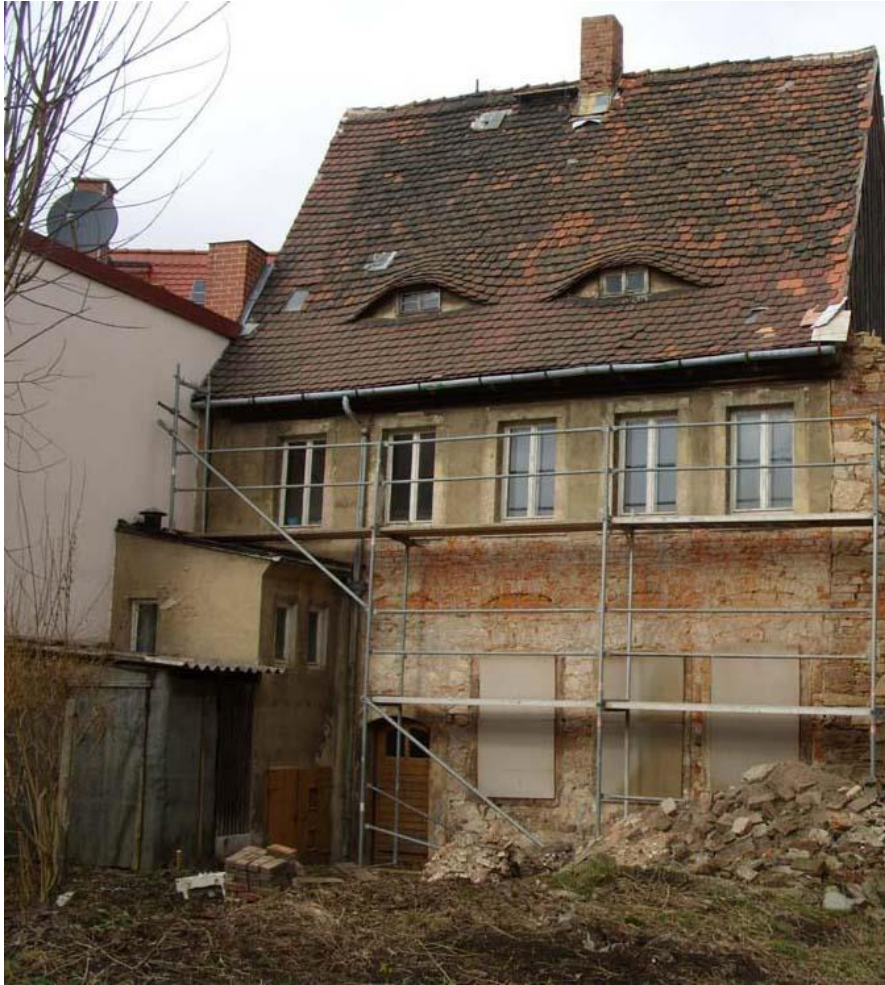
Bild 15: Ein Toilettenanbau, ein Schuppen und Müllberge „warten“ hier noch auf die Aufarbeitung.
