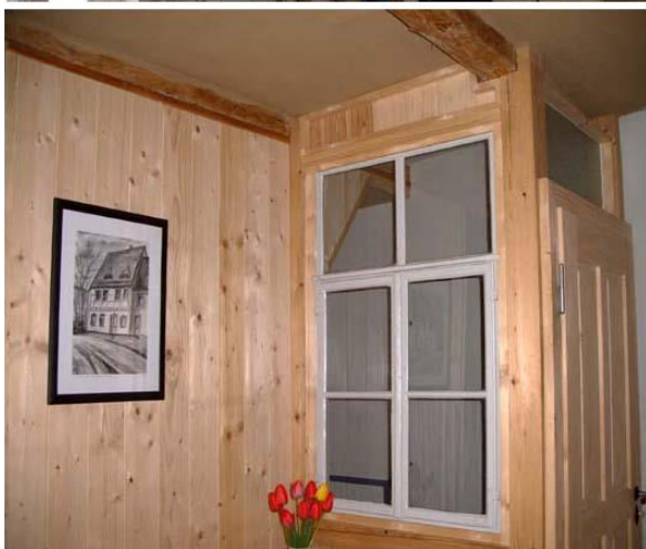
Bild 19: Selbst diese (grundsoliden!) Decken- und Wandbalken konnten wieder aufgearbeitet werden, und der Flurbereich im Obergeschoss fügt sich problemlos in den neuen wohnlich genutzten Bestand ein, in dem sogar ein altes Fenster seinen Platz am Treppenaufgang fand.
