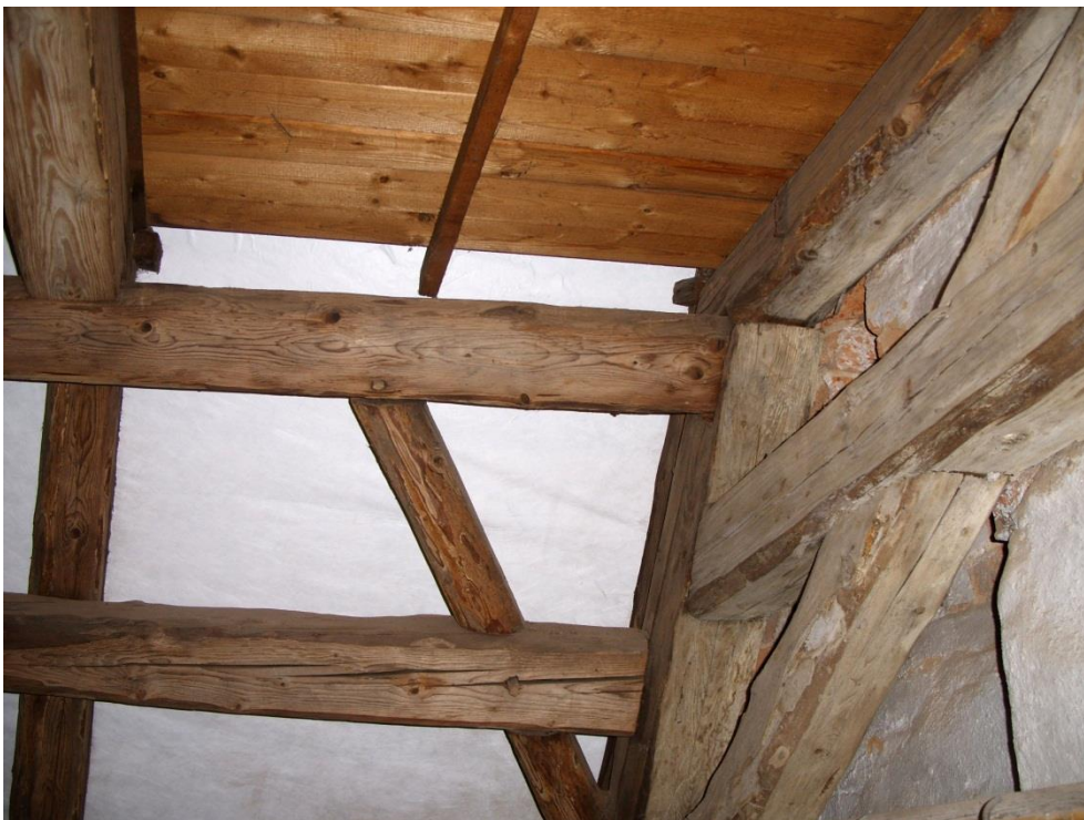
Bild 21: Eine stabile Tragkonstruktion sicherte den Bestand in den zwei sehr hoch ausgeführten Dachgeschoß-Etagen in mehr als 200 Jahren ohne sonderlichen Schädlingsbefall.
