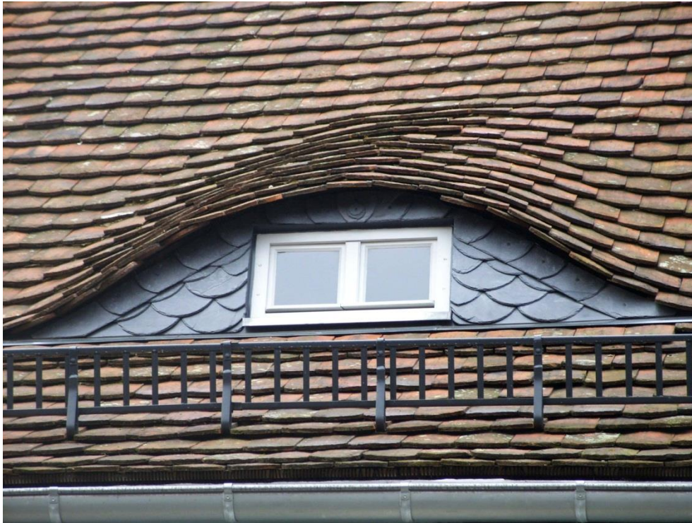
Bild 10: Nach Fertigstellung dieses Spließedaches war das Kulturdenkmal Badergasse 4 in Frankenberg endgültig gerettet.
