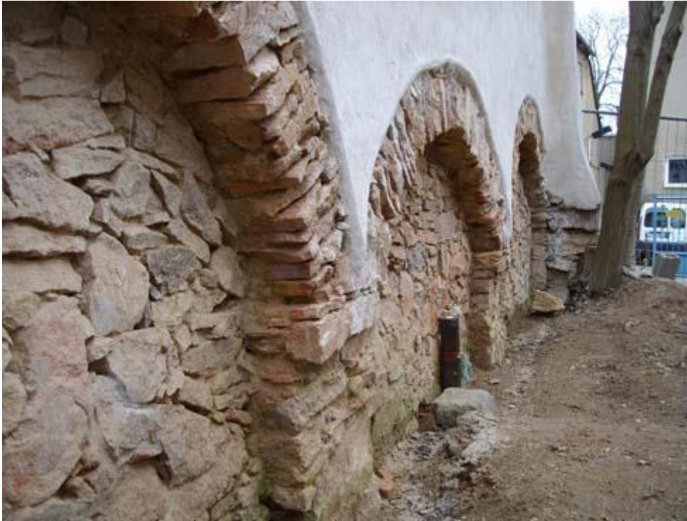
Bild 14: Die beiden mittleren Säulen der einst offenen Bögen in der uralten Giebelmauer weisen kapitellartige Auskragungen auf, die belegen, dass dies einst die Außen- bzw. Sichtseite vom Maschinenhaus der Untermühle war.
